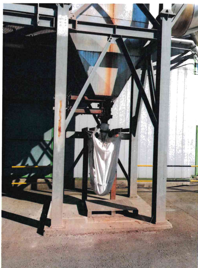
Big-bag de collecte des cendres sous économiseurs (catégorie de cendres sous chaudière)
